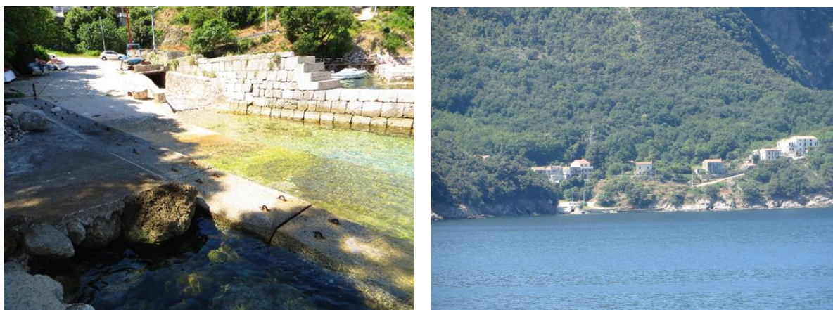
Slika 3.2-22: Priobalni dio trase kabela s vidljivim zaštitnim dijelom postojećeg kablenskog voda koji ulazi u more (lijevo) te pogled s morske strane na naselje i uvalu Merag
