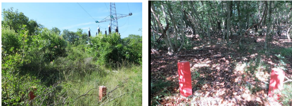
Slika 3.2-16: Zatečeno stanje na lokaciji zahvata zamjene kablenskog voda na kopnenoj dionici Mali Bok (crveni betonski stupići označuju trasu postojećeg 110 kV kablenskog voda)
