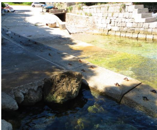
Slika 3.2-44: Priobalni dio trase kabela s vidljivim zaštitnim dijelom postojećeg kabelskog voda koji ulazi u more u uvali Merag, otok Cres
